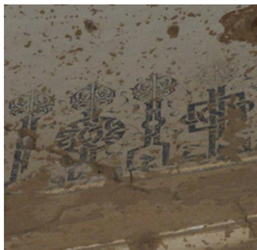
تصاویر ۸ و ۹. کتیبه زیر گنبد بنا و جزئیات اجرای گره تزئینی در آن - جزئیات کتیبه آسیب‌دیده و نقوش رنگ‌رفته بالای گنبد (عکس از: نویسنده).
